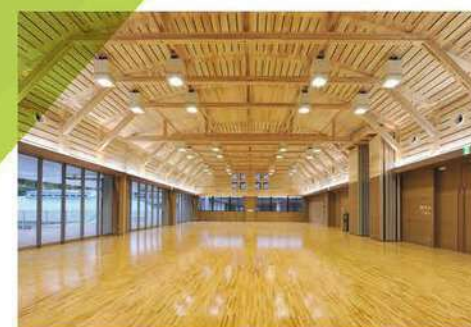
電灯・コンセント設備
